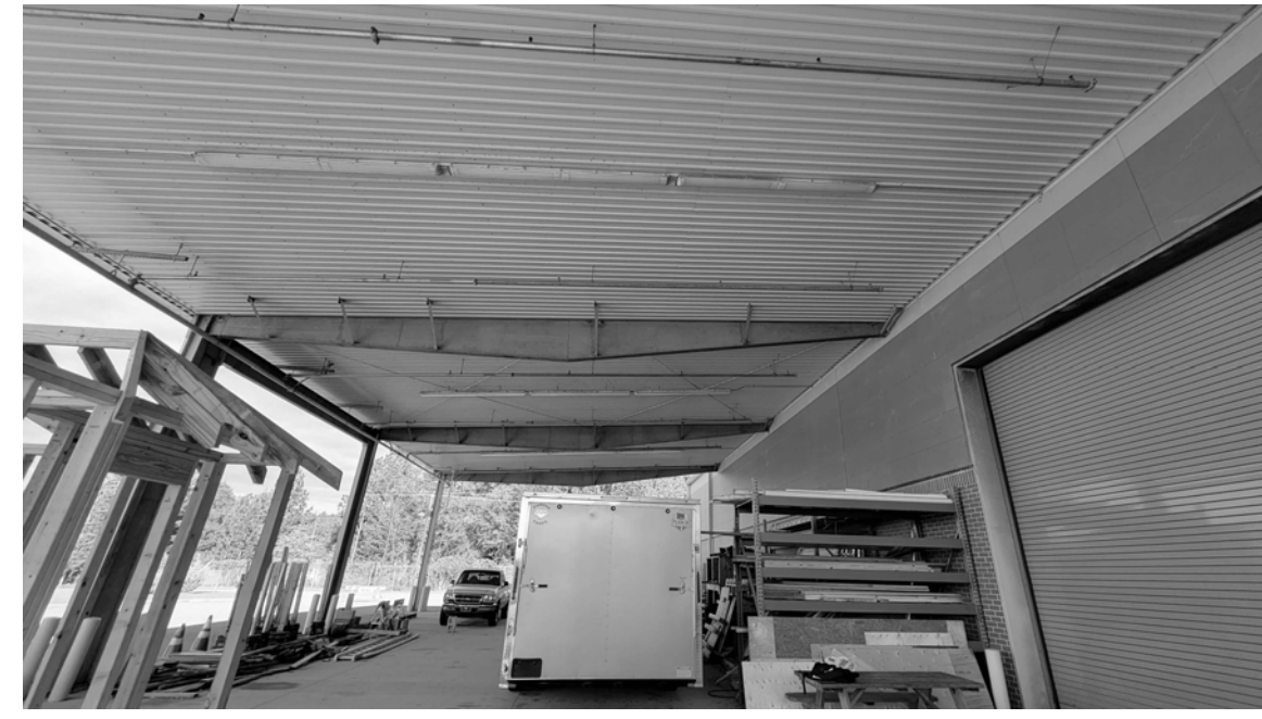
A CANOPY SPRINKLERS SCALE: N.T.S.
